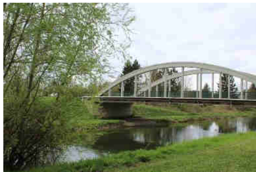
Ouvrage d'art au-dessus du Canal de l'Aisne
